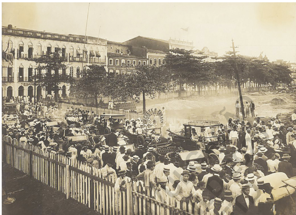
🕒 Construção da Praça da República na cidade de Belém, no Pará, em 1910.
